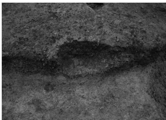
6. 同礎石撤去後（南より）
