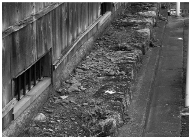
第 30 図 現存町屋の縁石
