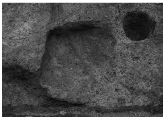
4. 同礎石撤去後（南より）
