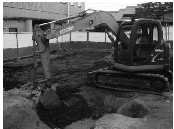
6. 重機による埋戻し
