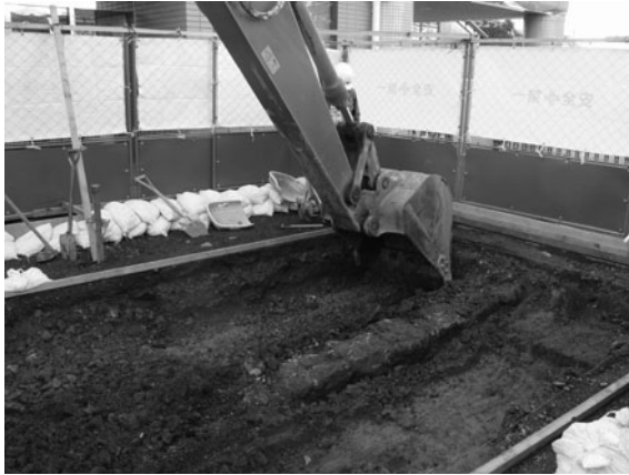
1. 重機掘削開始 (1 区)
