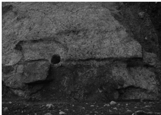
4. 同石材撤去後（南より）
