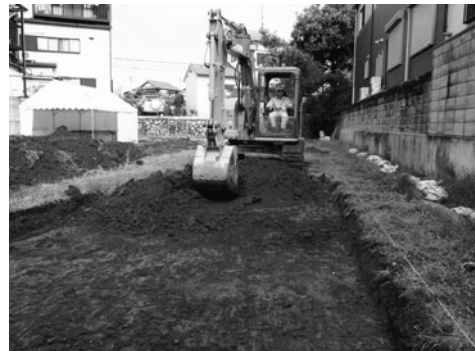
写真1 重機掘削状況（南西から）
